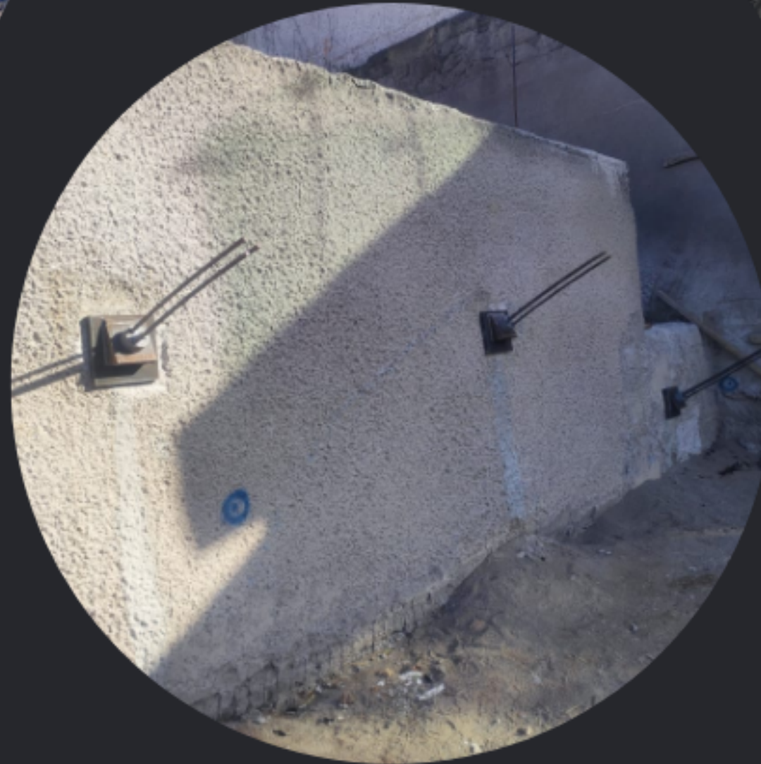
ANCLAJE Y CONCRETO LANZADO
